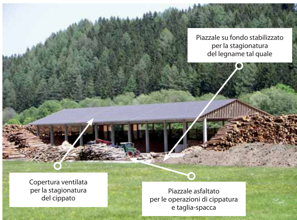
Figura 4.8.1 Piattaforma logistico-commerciale Pölstal (Stiria-Austria)
