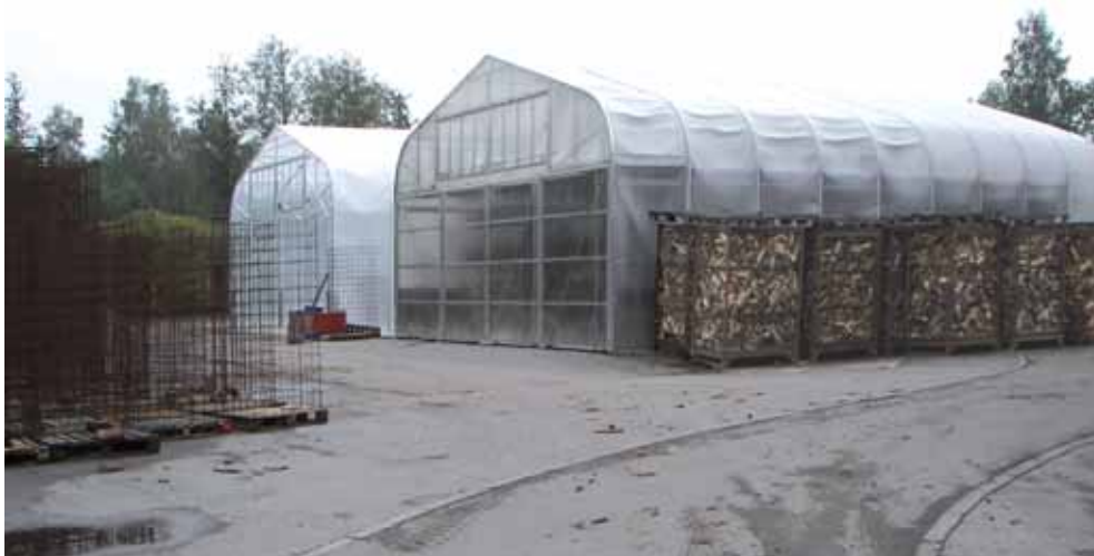
Figura 4.9.3 Serre per l'essiccazione della legna da ardere presso Biomassehof Allgäu (Baviera)
