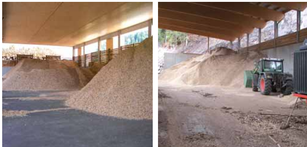
Figura 4.8.2 Esempi di struttura architettonica di due piattaforme biomasse in Austria (Pölstal, Stiria) e in Italia (Deutschnofen, Bolzano)
